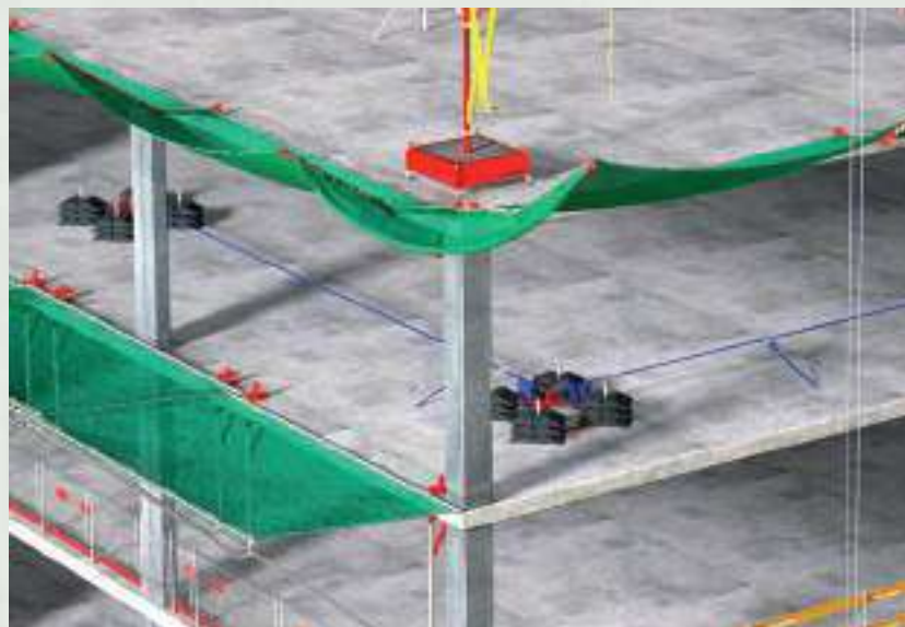
Linia życia podpięta do balastów bezwładnościowych “SPIDER”.
